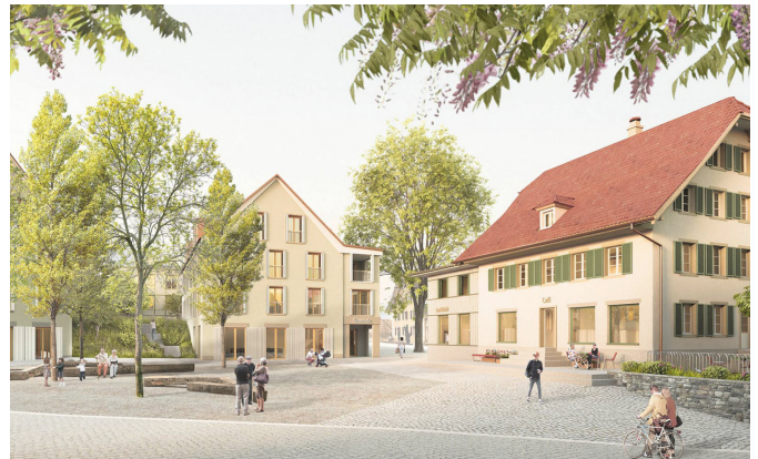
Dank der Dorfkernentwicklung Knutwil erhält das Dorf eine neue Mitte: ein neuer grosszügiger Begegnungsraum, Einkaufsmöglichkeiten, Gastronomie sowie Wohnungen beleben das Dorf. (Bildrechte: ARGE Jäger Egli AG und Jäger Charpié Architekten GmbH, Siegerprojekt: «Im Chrüz»)
